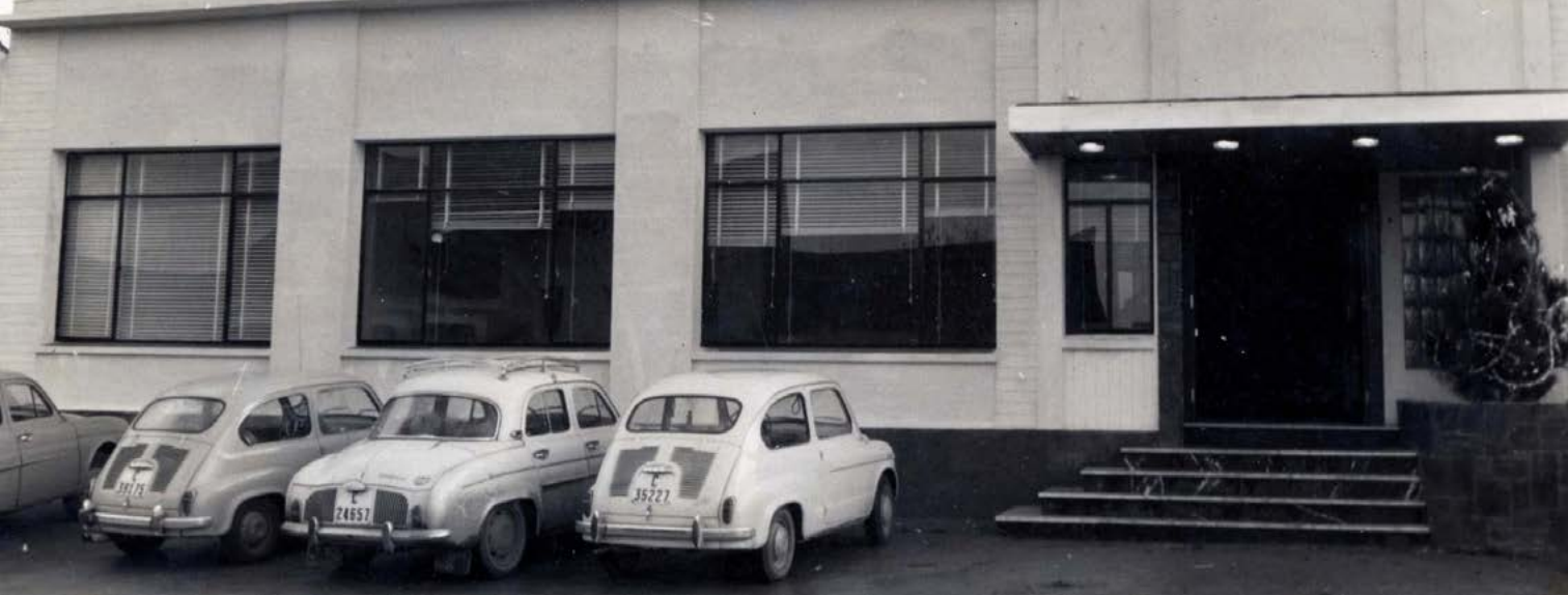
◀ O “Salón Pelayo” na Avenida de Galicia, onde ten actualmente as oficinas Abanca.
