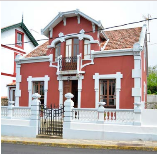
▲ Casa Montero Cabana na Avenida do Seixo. Consiste nunha vivenda popular reformada en 1925 por emigrantes retornados. As fachadas contan con abundante ornamentación elaborada con cemento.
