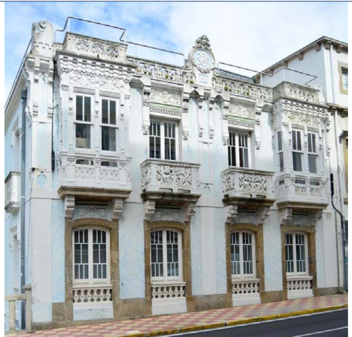
▲ Casa de Gelpi na Avenida de Galicia, datada en 1910 como queda constatado na propia fachada. Conta con abundante ornamentación de tipo vexetal elaborada en cemento. Destaca a presenza de rostros femininos na mesma.
