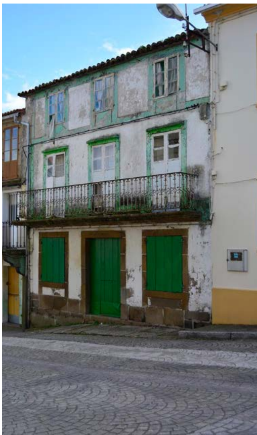
▲ Fachada do século XVIII na Rúa San Telmo. Ademais a vivenda esconde unha singular fachada posterior cara a Rúa San Fernando con corredor e soportal
