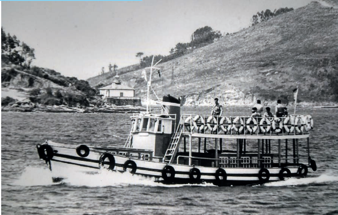
Vila de Mugardos foi construída no estaleiro de Jerónimo Vila no 1942.
