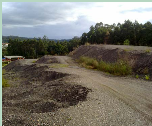
▲ Foto dos residuos asfálticos contaminantes depositados en Vilar do Colo, Cabanas.
